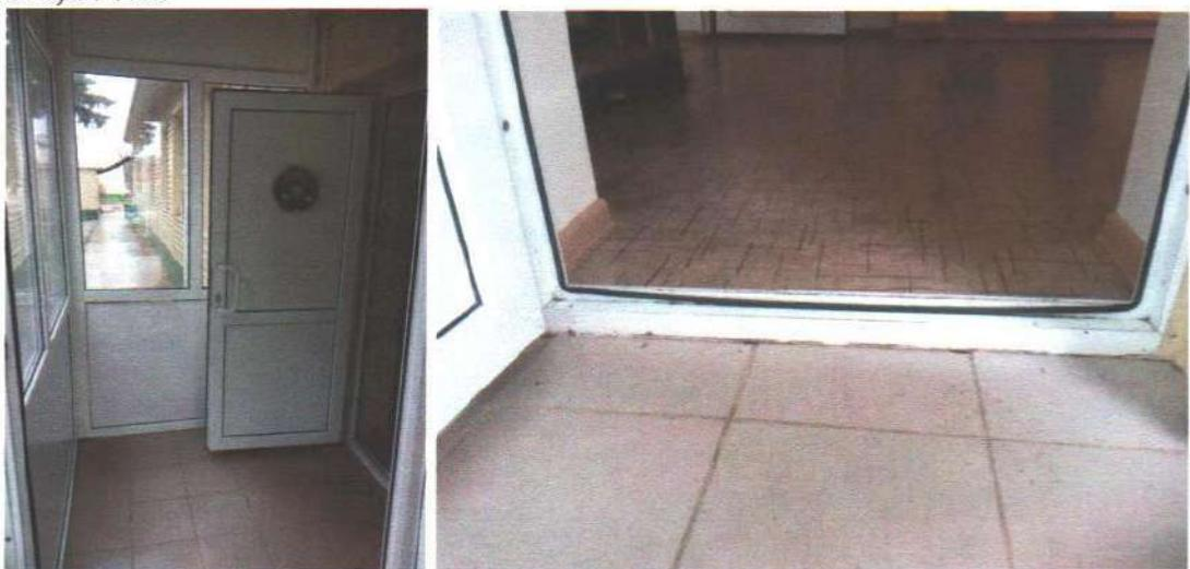
Глубина тамбура 1,82 м., ширина тамбура 1,46 м – что не соответствует требованиям. Глубина тамбуров и тамбур-шлюзов при прямом движении и одностороннем открывании дверей должна быть не менее 2,45 м при ширине не менее 1,6 м.
